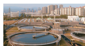
废水处理设施
