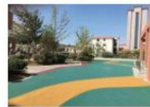
小区透水混凝土步道
