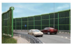
公路上安装隔音屏障
