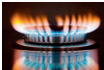
图 7-11 燃气燃烧出现黄色火焰
