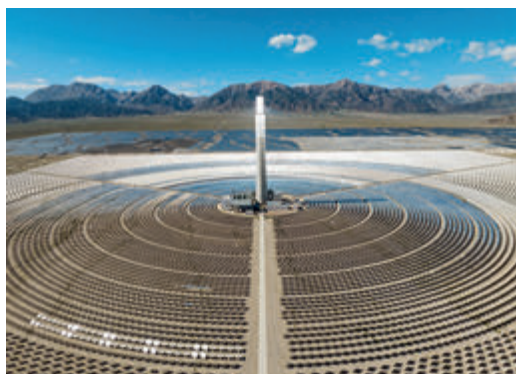
青海德令哈熔盐光热发电项目
