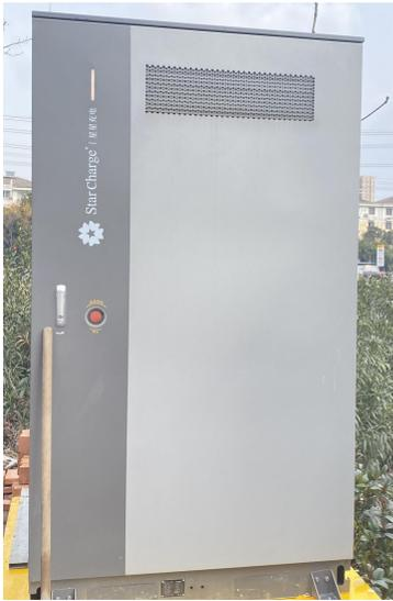
储能柜储存的是电能，这里的电能，可以通过光伏太阳能电池板发的电，也可以是市电充电，其实，储能柜如果作为备用电源应用的话，可以理解为是一个大型的充电宝，当市电停电时，就可以通过储能柜给负载（家里的电器设备及其他用电设备）供电，一般储能柜都是 KWH(能量单位，1KWH=1 度电)级别的，客户可以根据负载的用电量，选配相应大小的储能柜，华纽也会给出相应的方案。
