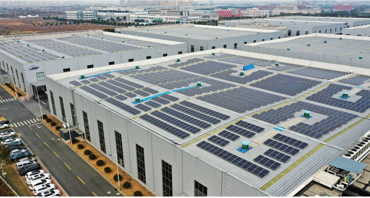
1月18日,武高新凤翔工业园厂房上的屋顶光伏电站已投入使用。近年来,武进区把推进光伏发电作为实现“双碳”目标的重要举措,积极推广绿色建筑应用,大力发展“自用为主、余电上网”分布式光伏发电,有序推进渔光、农光互补光伏电站,因地制宜推进风电计划。2021年,全区共办理工商用户项目备案101个,总装机规模75.54兆瓦,可减少排放二氧化碳7.554万吨。
